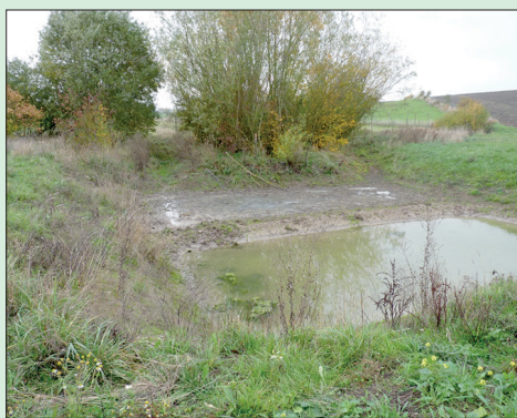
Réalisation d'un bassin de décantation et filtration en sortie de drainage suivie par la Chambre d'agriculture
